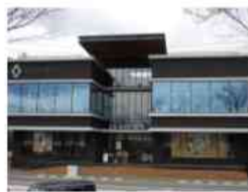
写真2 くらすわ CLASUWAのファサード
