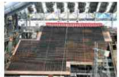
図1 修復された素屋根
