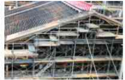
図2 解体調査の結果「瓦葺屋根」から「石置き屋根」の勾配（3寸5分）に戻された
