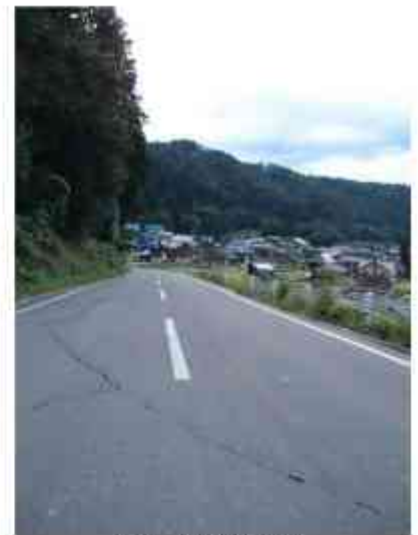
図1 道路の亀裂
