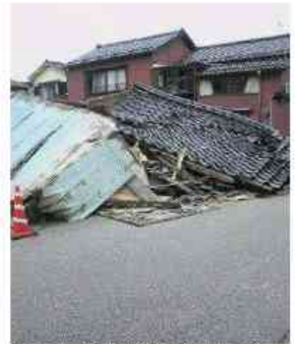
写真1 地震直後の輪島市の様子 (2007年3月25日)
