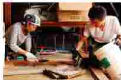
図2 自ら施工している改修の様子
