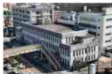
写真4 本丸会館本館
