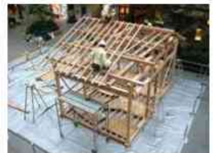
図5 伝統構法の建前
