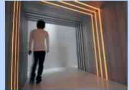
図2 アルミリングモックアップ 構造体と照明の一体化
