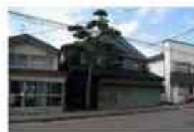
図2 柏崎市 黒崎家住宅 中越沖地震で倒壊。明治時代中期の火災後、移築された土蔵造の町家
