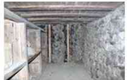
写真3 業務用の風穴の内部
