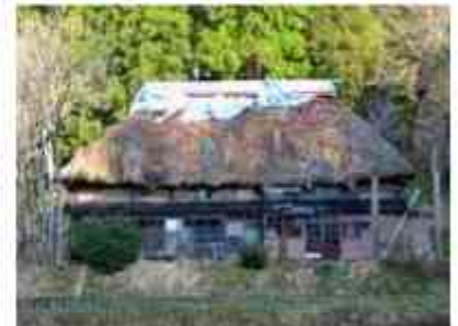
図3 再生前の古民家
