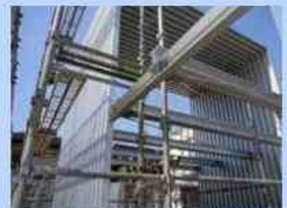
図4 アルミニウム構造現場
