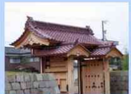
写真3 幅復元された舎人門
