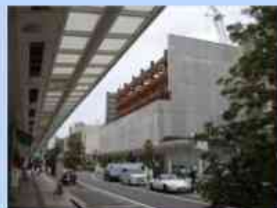
住宅建設が進む福井駅西地区
