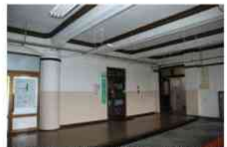
【写真4】 1階の間仕切りで隠された円 柱
