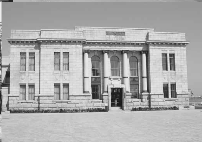
左上：旧師団長官舎移築復原（上越市） 右上：江戸時代からの雁木の町屋（上越市） 左下：旧新潟税関庁舎（新潟市みなとぴあ） 右下：旧第四銀行住吉支店移築復原（新潟市みなとぴあ）
