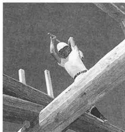
梁をくむ職藝学院学生 (学院パンフレットより)
