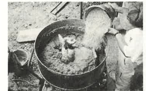
壁土に石膏を混ぜる
