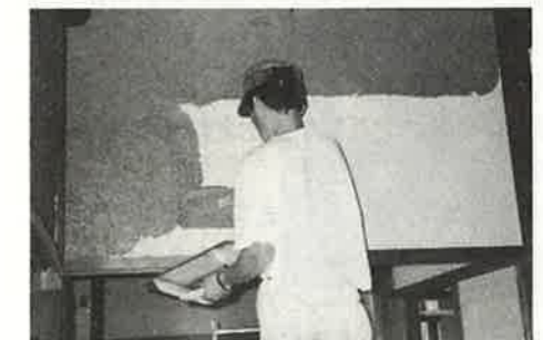
石膏入りの土壁を塗る
