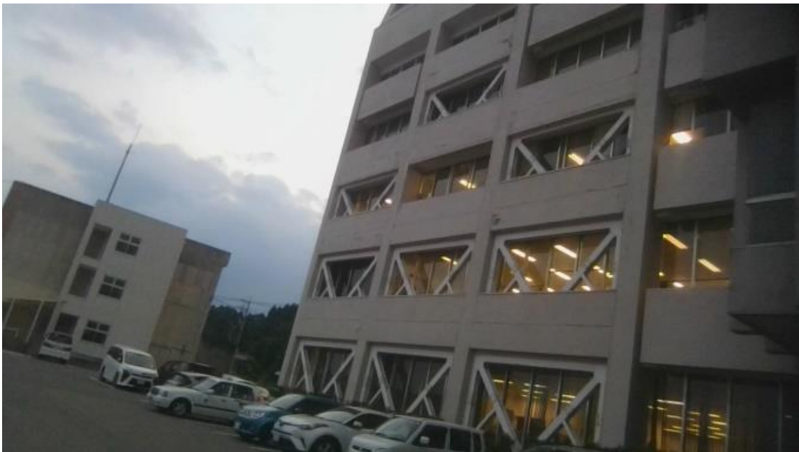
珠洲市役所（耐震補強済み）被害なし
