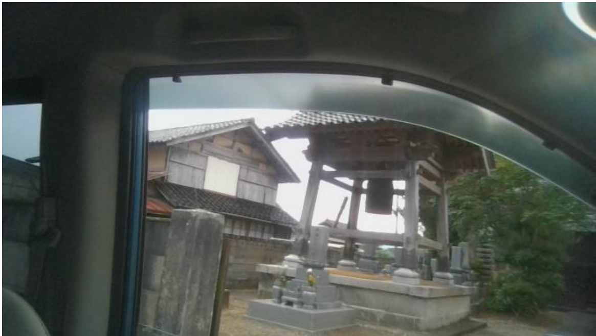
基礎がずれた鐘楼(37.4475639, 137.2890496)
