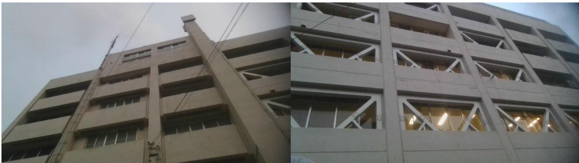
珠洲市役所（煙突の被害はなさそう）
