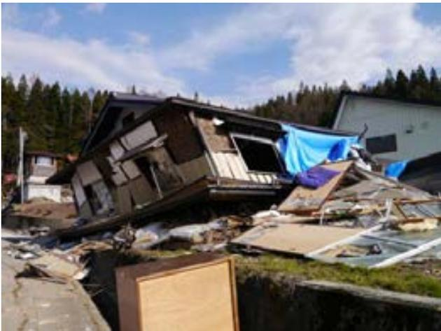
写真 25 土壁の在来構法 2 階建て住宅の倒壊
