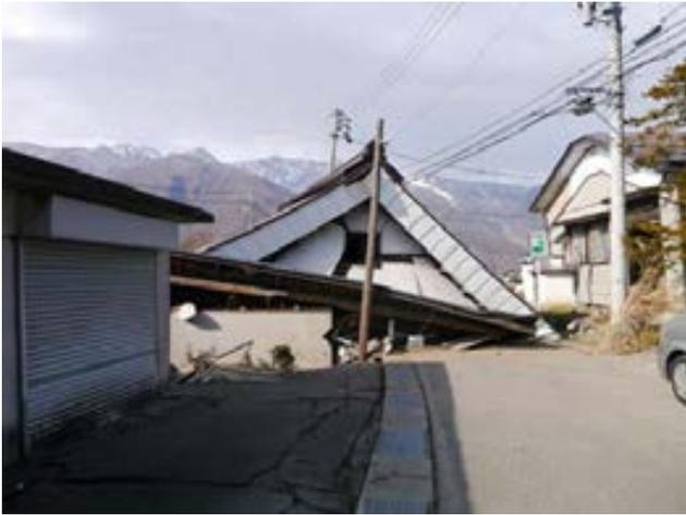
写真 15 伝統構法建物の倒壊
