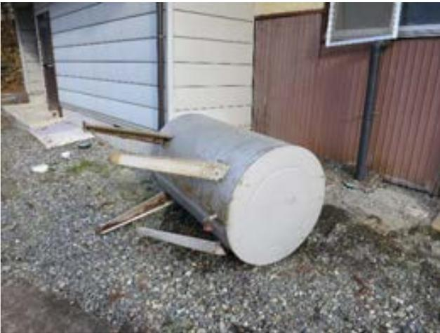
写真 75 灯油タンクの転倒
